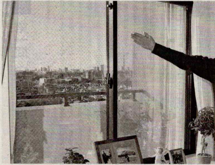
▲ 真空ガラス「スペーシア」に交換したリビングの窓(千葉県浦安市で)
